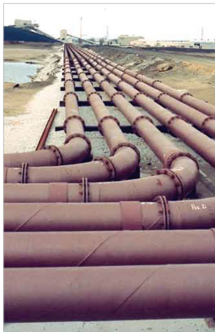
Các ống dẫn loại bỏ tro trên toàn thế giới được lót bằng ABRESIST có tuổi thọ hơn 30 năm. Nhà máy điện này của Mỹ vận hành hơn 10.000 mét đường ống có đường kính trong 294 mm.
