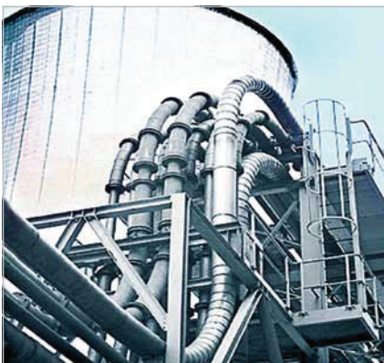
Đường ống dẫn tro bay trong nhà máy điện chạy bằng than.
