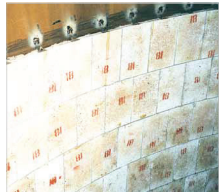
Bảo vệ chống mài mòn ở nhiệt độ cao trong xyclon của một nhà máy lò cao ở châu Âu
