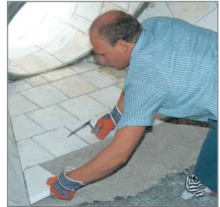
Lớp lót KALCOR cho phần phễu của bộ phận thu gom bụi thiêu kết của một xưởng thép.
