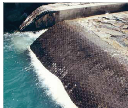
Đập thủy lợi được bảo vệ bởi ABRESIST
