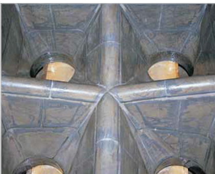
Phễu xả vật liệu ở bất kỳ hình dạng nào đều phù hợp cho ABRESIST làm lớp lót chống mài mòn.
