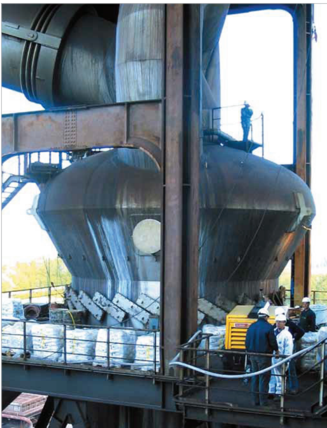
Đầu vào máy lọc hơi trong một nhà máy thép được lót bằng cách phun hợp chất Kalcret-BTS
