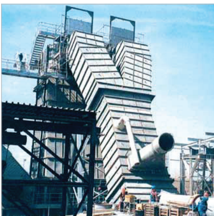
Lớp bảo vệ đáng tin cậy bằng KALCRET-BNY của đường ống thu bụi của máy làm mát clinker được lắp theo những chi tiết tạo hình làm sẵn có tích hợp cách nhiệt.
