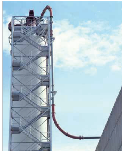
Các chỗ uốn khuỷu và phần mở rộng thẳng của ống dẫn nạp liệu đến silo xi măng đã được lót bằng ABRESIST
