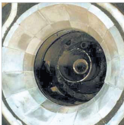
Phễu buồng đốt được làm bằng KALSICA-N của một nhà máy điện
