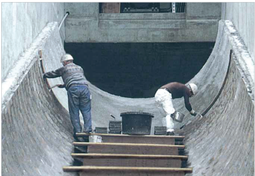
Gầu tải kiểu trục vít được sử dụng khá thường xuyên để vận chuyển trong các nhà máy xử lý nước thải. Để khe trống hình vành khuyên vận hành thông suốt và chuẩn nó đòi hỏi cần phải được bảo vệ chống mài mòn. ABRESIST đã được sử dụng thành công cho mục đích trên ngay cả ở đường kính 3.000 mm và 15.000 mm chiều dài
