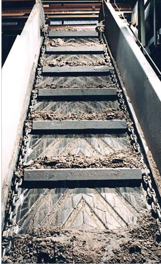
Băng tải xích để loại bỏ tro ướt trong một nhà máy điện. Các rãnh thoát nước được đúc vào lớp lót làm giảm việc chuyển tải nước không mong muốn đến khu vực xả thải nhờ đó làm giảm tốc độ tiêu thụ nước.
