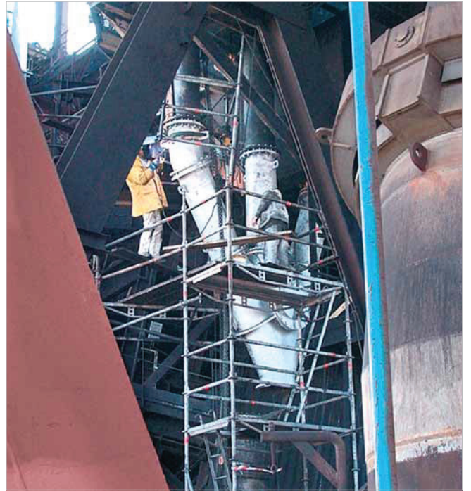
Đường ống cân bằng áp suất được lắp đặt gần lò cao; phân kim loại cơ bản có độ dày 30 mm, độ dày của lớp phủ hàn cứng KALMETALL-W 100 đo được là 6 mm; đường kính 450 mm
