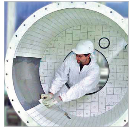
Phễu hình bát giác trong một nhà máy thép; gạch KALOCER dày 50 mm đã được cắt định hình ba chiều
