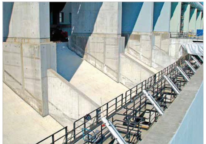
Cầu tàu than cốc được bảo vệ bằng KALCERAM-K trên bề mặt trượt, bằng KALSICA-N ở khu vực có độ mòn cao và bằng KALMETALL-C trong khu vực chịu ứng suất và đập
