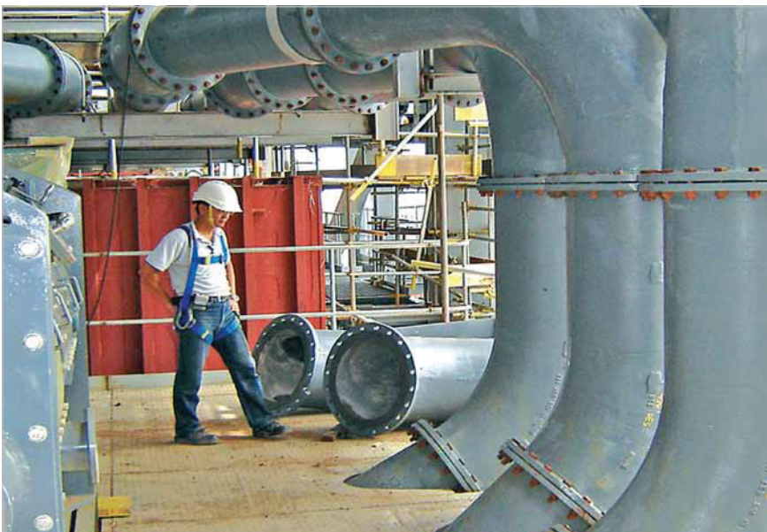
Các ứng dụng điển hình của KALMETALL-C đúc cứng là các hệ thống ống; đây là một ống dẫn than nghiền của một nhà máy điện ở Đông Nam Á
