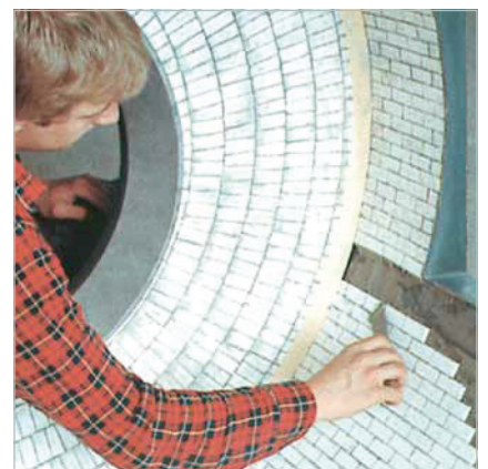
Tấm ghép KALOCER dày từ 1,5 đến 12 mm cho phép sử dụng linh hoạt; chúng được cố định bởi hợp chất đông kết epoxy KALFIX
