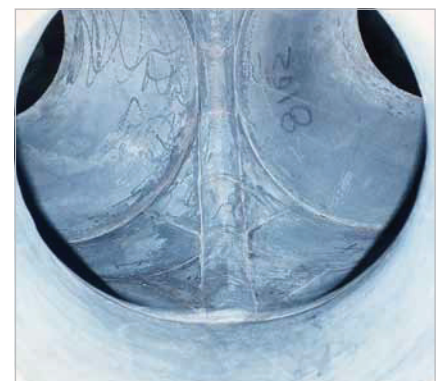
Phần nối ống được bọc KALSICA
