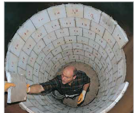
Các loại vữa có gốc kali silicat được sử dụng trong trường hợp ứng suất nhiệt cao
