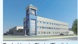
Tsubakimoto Chain (Tianjin) Co., Ltd.
